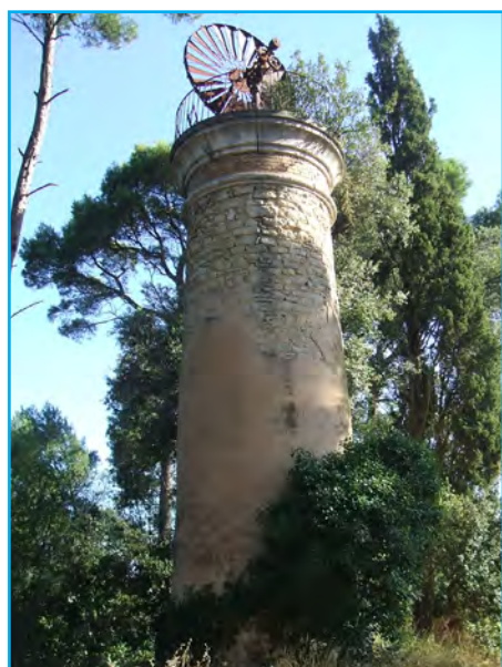
Tourelle lieudit Bel Air
