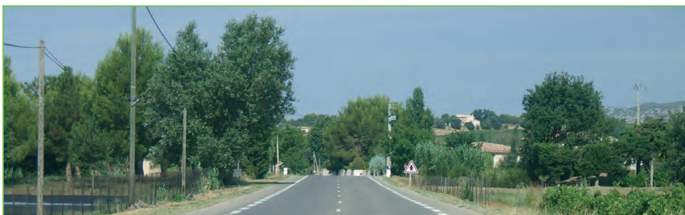
Paysage plus confus au droit de la station de pompage
