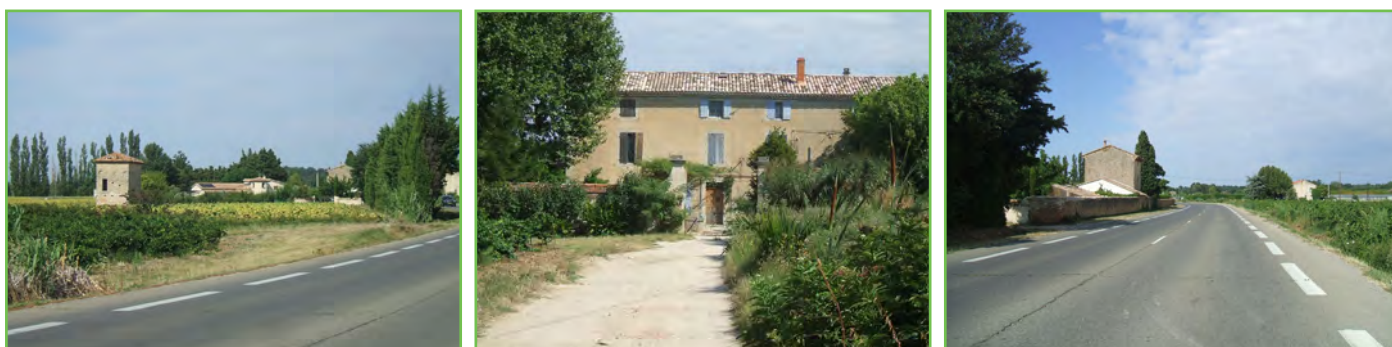
Vues vers l'ouest (au centre : domaine de l'Espace)
