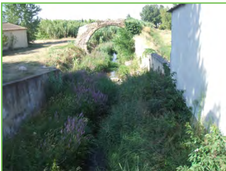
Le Brégoux au droit de la RD7
