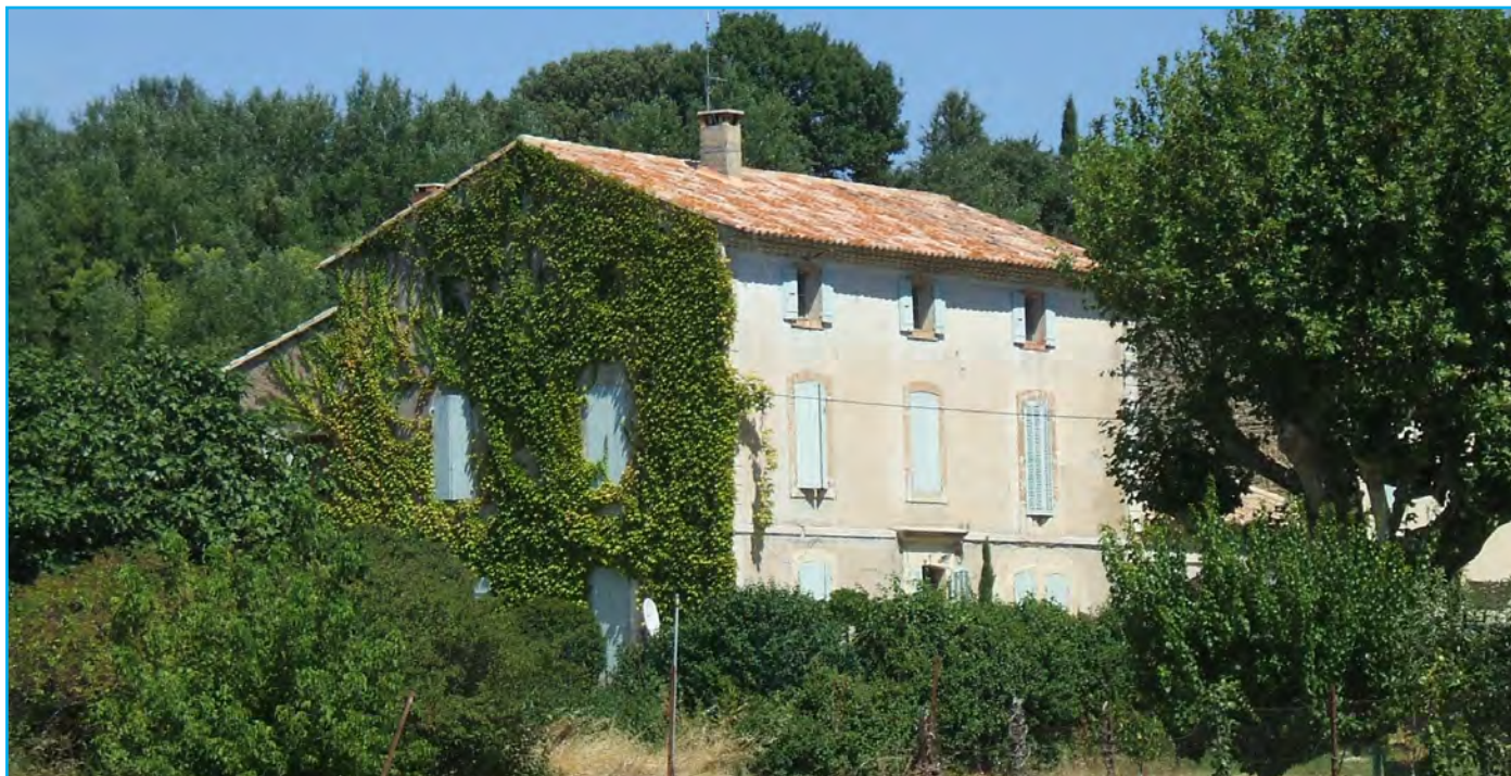
Bâti au lieudit La Ginestière
