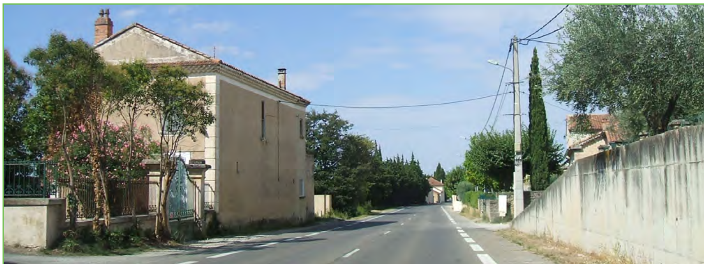
Bâtiment de qualité au lieudit le Couvent
