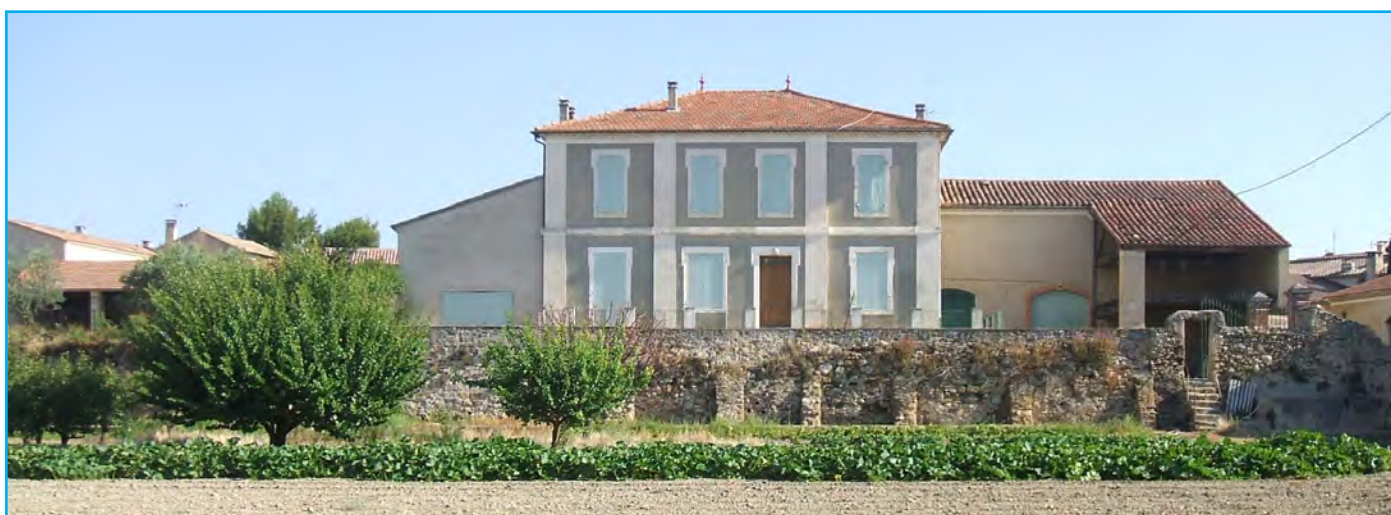
Bâti situé sur les parcelles G 719 et G 180, au nord immédiat du centre ancien
