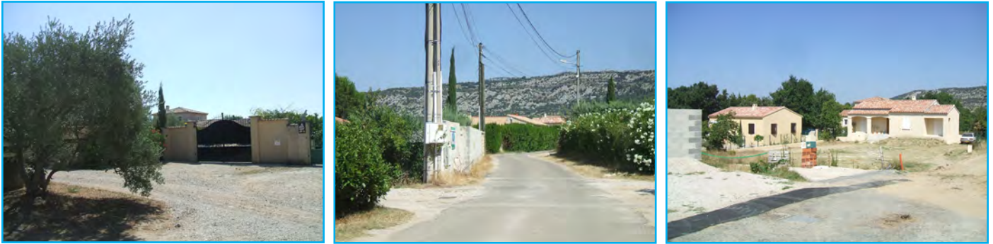
Des habitations de type pavillonnaire en zone UDa ou NB du POS devenu caduque située au nord
