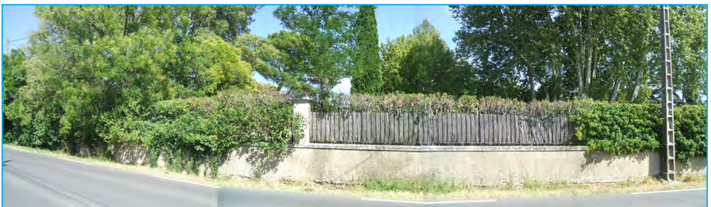
Vues depuis la RD 7 et la 126 vers la zone UDa du POS, au lieudit Les Bouteilles et ses espaces paysagers
