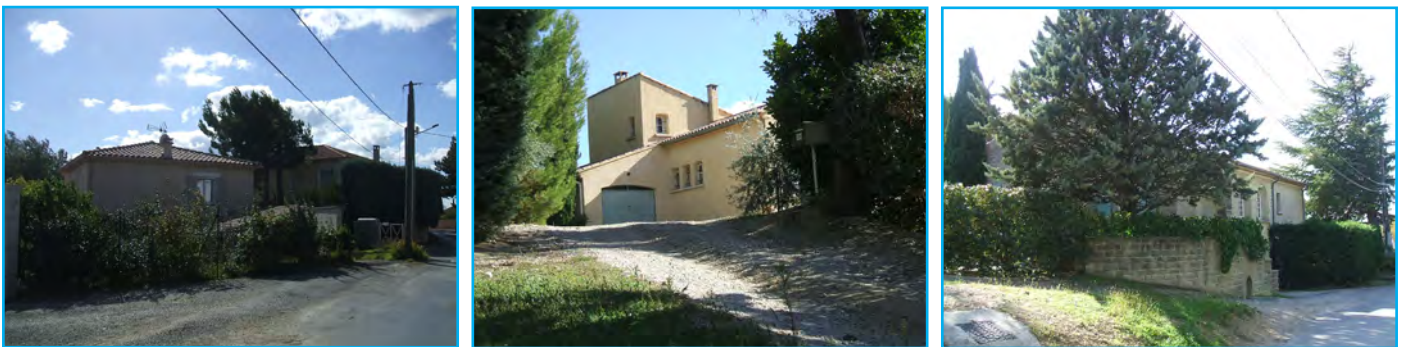
Les constructions en zone UDa du POS devenu caduque, au lieudit Le Cros
