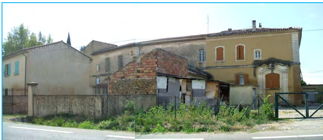
Bâti situé sur la parcelle A 1121
