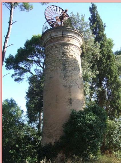
Tourelle au lieudit Bel Air
